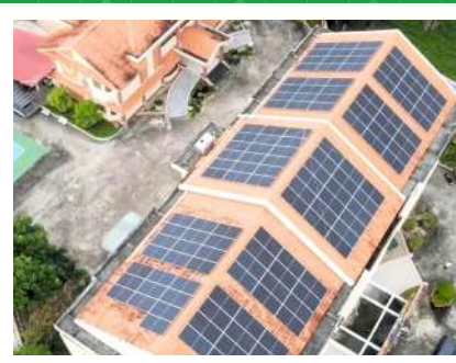
Công trình cho Trụ sở hành chính 100kWp tại Tây Ninh
