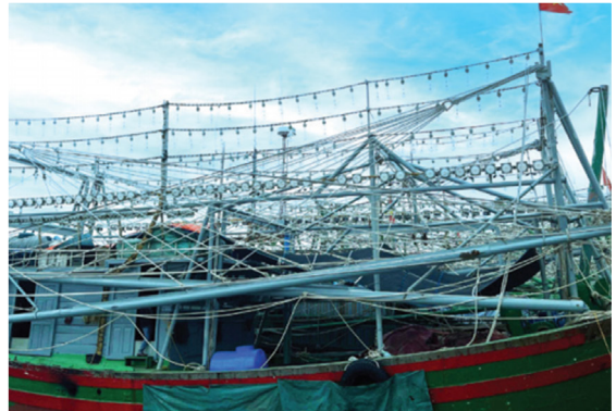
Mô hình lắp đặt đèn LED đánh cá tại Hải Phòng
