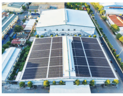
Công trình cho nhà xưởng 1,3MWp tại Quế Võ, Bắc Ninh
