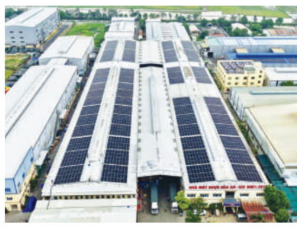
Công trình cho nhà xưởng 1,5MWp tại Thuận Thành, Bắc Ninh
