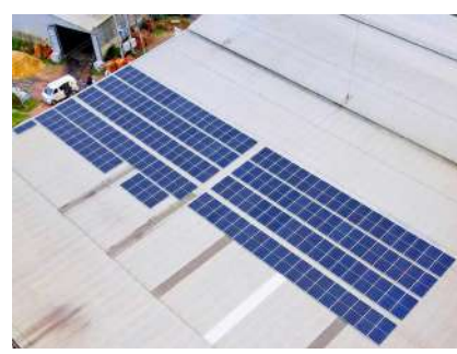
Công trình cho nhà xưởng 100kWp tại Tây Nguyên
