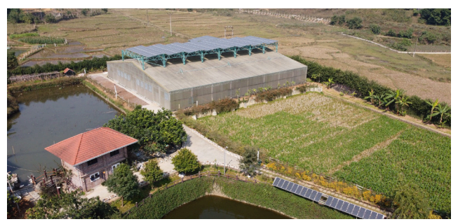
Công trình trong nhà màng, nhà kính
