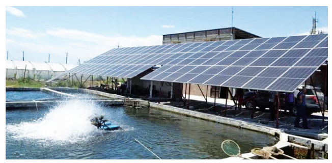
Công trình trong nuôi trồng thủy sản
