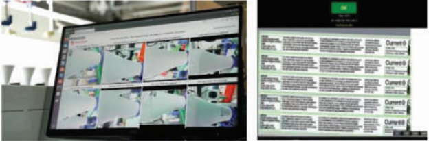
Kiểm tra tự động thông số điện, an toàn điện, an toàn cơ
