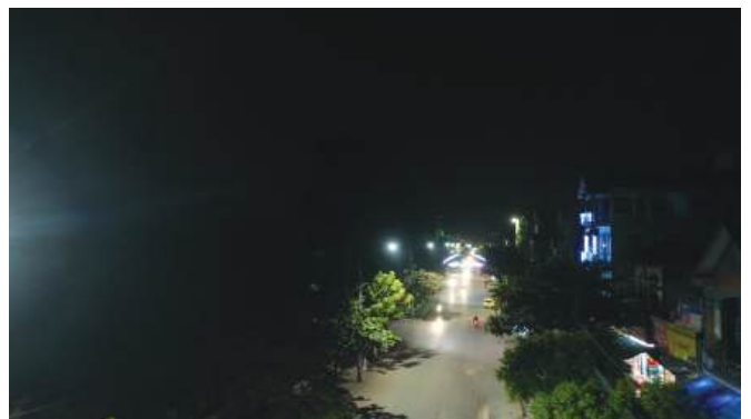
Cài tạo, sửa chữa điện chiếu sáng các tuyến đường trên địa bàn thành phố Sông Công, tỉnh Thái Nguyên
