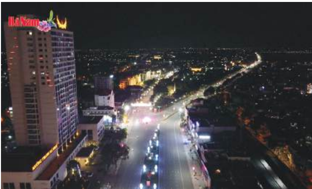
Cải tạo hệ thống chiếu sáng tuyến đường Lê Duẩn, Hà Nam
