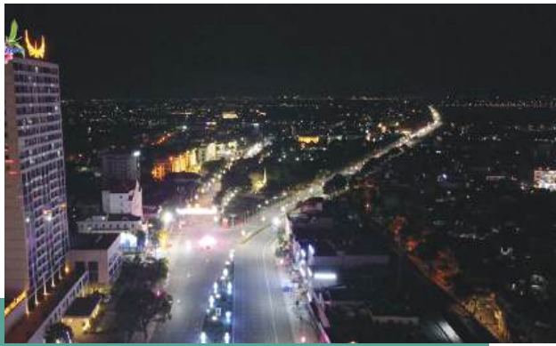
Cải tạo hệ thống chiếu sáng tuyến đường Lê Duẩn, Hà Nam
