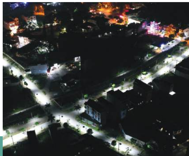
● Lắp đặt đèn LED năng lượng mặt trời huyện Trùng Khánh, tỉnh Cao Bằng
