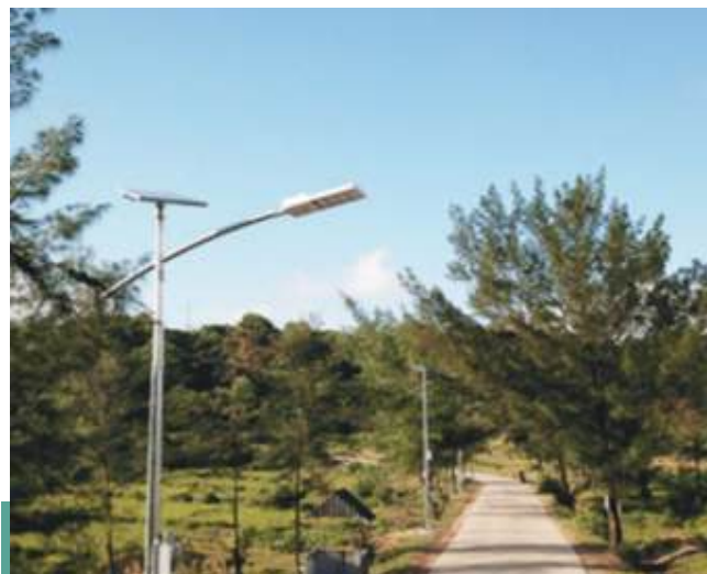
● Lắp đặt hệ thống đèn chiếu sáng đường thôn Đảo Trần, xã Thanh Lân
