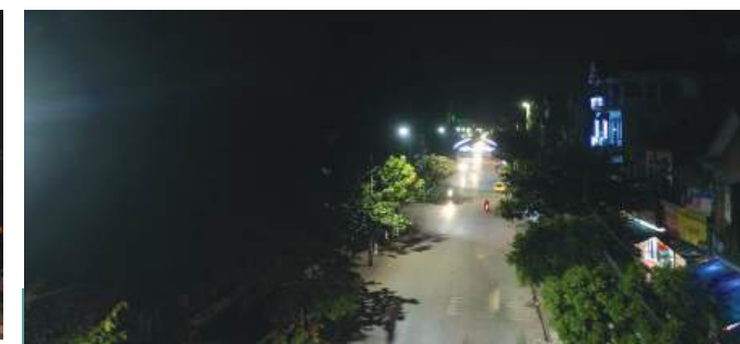
● Cải tạo, sửa chữa điện chiếu sáng các tuyến đường trên địa bàn thành phố Sông Công, tỉnh Thái Nguyên
