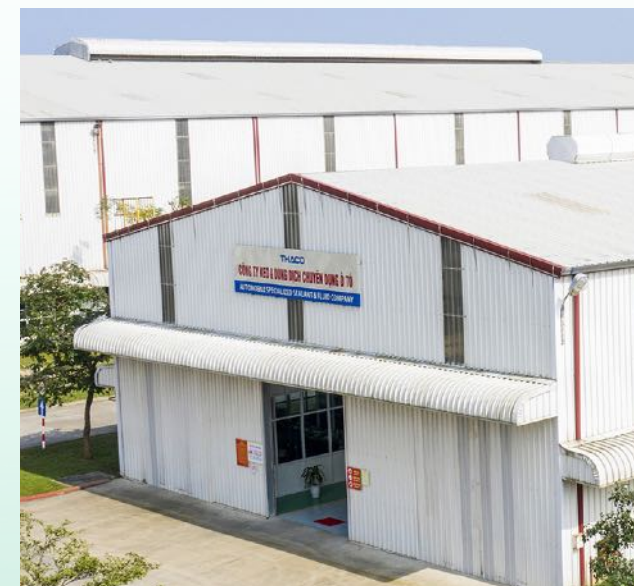
NHÀ MÁY PHỤ TRỢ Ô TÔ THACO CHU LAI
