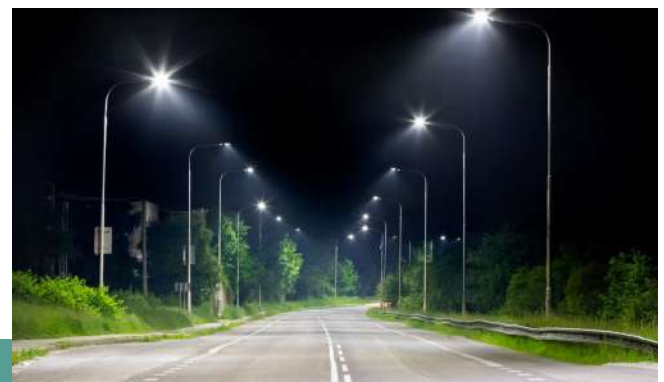
Cải tạo hệ thống chiếu sáng TP. Hưng Yên
