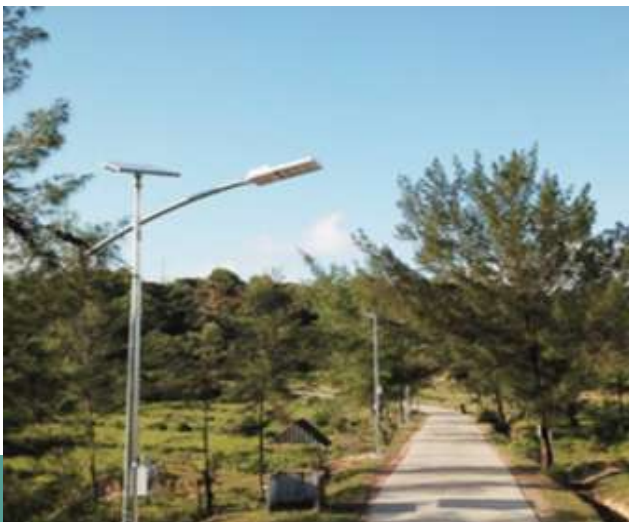
● Lắp đặt hệ thống đèn chiếu sáng đường thôn Đào Trần, xã Thanh Lân
