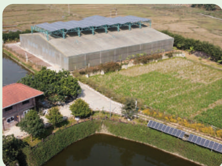
Nhà màng, nhà kính
