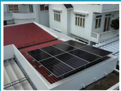
Công trình tại Cần Thơ
