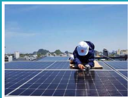
Công trình tại Đà Nẵng
