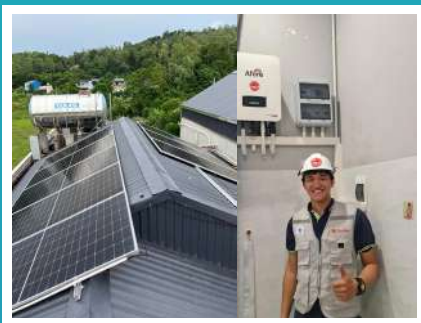
Công trình tại Cô Tô
