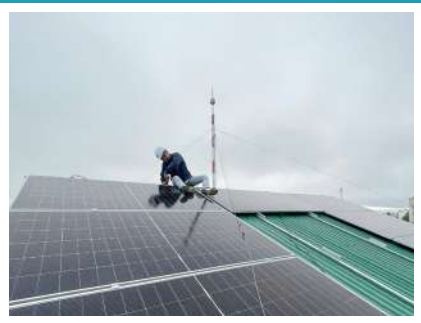
Công trình tại Tây Nguyên
