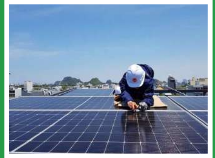
Công trình tại Đà Nẵng
