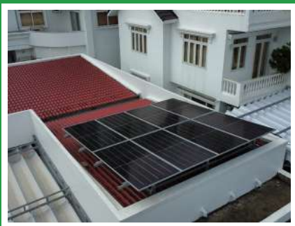
Công trình tại Cần Thơ
