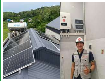
Công trình tại Cô Tô
