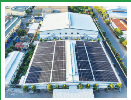
Công trình cho nhà xưởng sản xuất phích nước & thủy tinh 1,5MWp tại Quế Võ, Bắc Ninh
