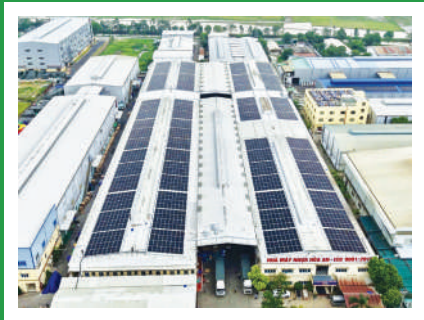
Công trình cho nhà xưởng 1,5MWp tại Thuận Thành, Bắc Ninh
