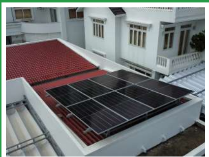
Công trình tại Cần Thơ
