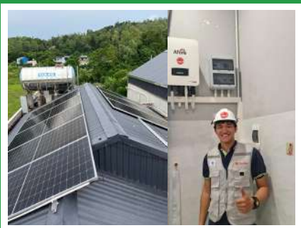
Công trình tại Cô Tô
