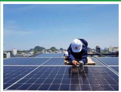
Công trình tại Đà Nẵng
